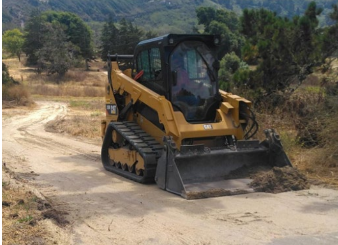
Calle King Construction
